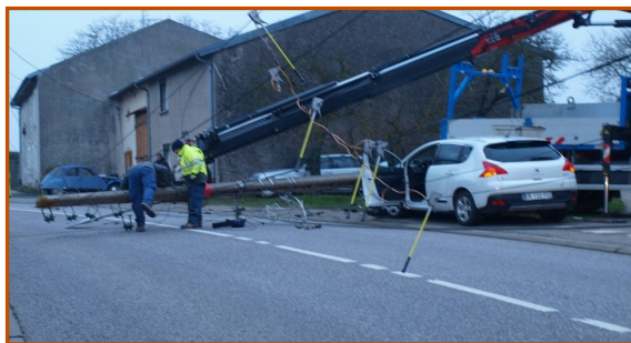
Janvier 2017 , un accident de la circulation s'est produit dans la commune impliquant un seul véhicule. Une voiture venant d'Essey-et-Maizerais a percuté un poteau électrique, qui, sous la violence du choc est tombé en travers de la rue de la croix.
