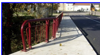
Fin Août 2016 , installation de deux balustrades toutes neuves pour finaliser les travaux du pont.
